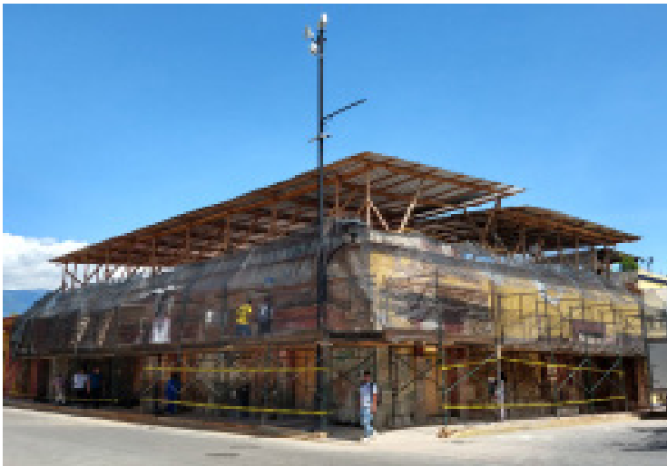
Figura 6 Proceso de rehabilitación de inmueble patrimonial
