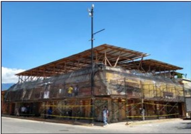
Figura 6 Proceso de rehabilitación de inmueble patrimonial
